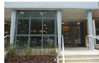
La maison départementale de l'Autonomie de la Manche (Source : Conseil Départemental)
